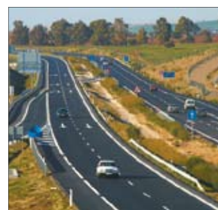
La autovía A-381 en Jerez de la Frontera. JUNTA ANDALUCÍA
